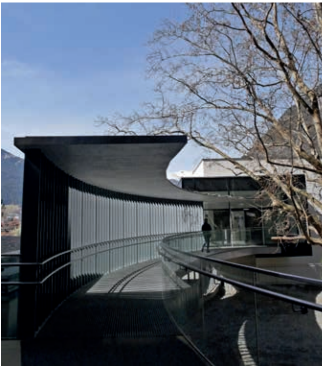
Das Krankenhaus und das Parkhaus sind durch die neue Fußgängerbrücke verbunden.
